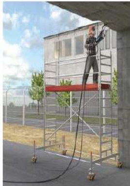
Abb. 99 Manuelle Abbrucharbeiten
