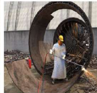
Abb. 115 Brennschneidarbeiten
