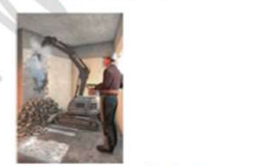
AR-057, V2: ferngesteuertes Abbruchgerät
