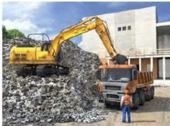
Abb. 125 Verladung Abbruchmaterial
