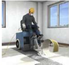
Abb. 90 Ausbau Fußbodenbelag
