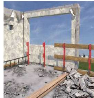
Abb. 111 Absturzsicherung vor der Demontage anbringen
