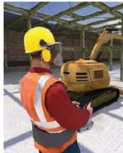
Abb. 95 Ferngesteuerte Abbruchmaschine
