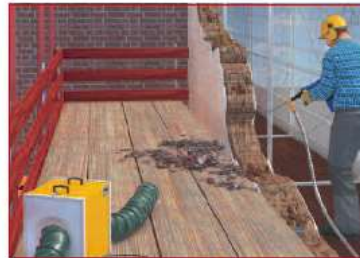
AR-002, V 2 Absturzsicherung durch Seitenschutz bzw. durch Fassadengerüst
