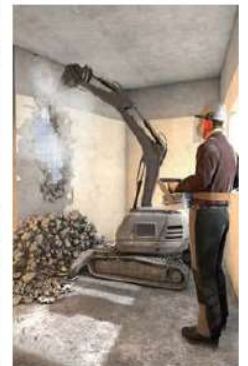
Abb. 88 ferngesteuertes Abbruchgerät
