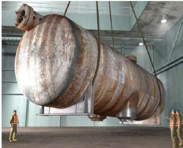
Abb. 113 Demontage Kessel
