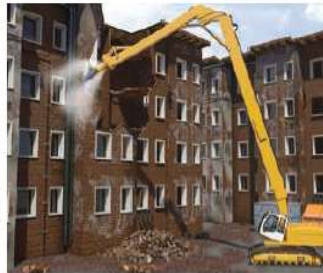
Abb. 84 Abbruchbagger mit Longfrontausrüstung
