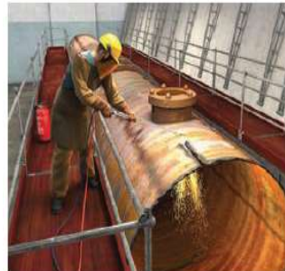
Abb. 114 Rückbau Rohranlage
