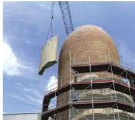
Abb. 109 Rückbau einer Gebäudehülle
