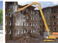
Baustein C302: Abbruchbagger mit Longtrifortaurüstung
