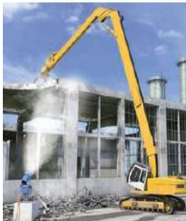
Abb. 93 Abbruchbagger mit Longfrontausrüstung
