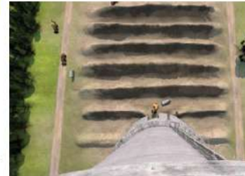
Abb. 119 Fallbett für eine Schornsteinsprengung
