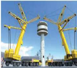
Abb. 108 Demontage eines Turms aus Stahlbeton
