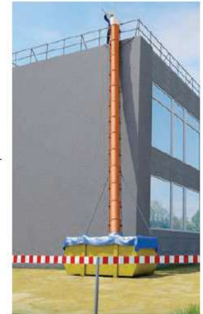
Abb. 103 Absturzsicherung an Schuttrutsche
