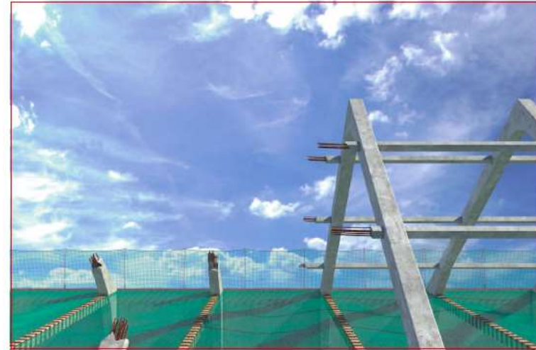
AR-005, V 3 Schutznetze und Randsicherung als Schutzmaßnahme beim Rückbau von Dachkonstruktionen
