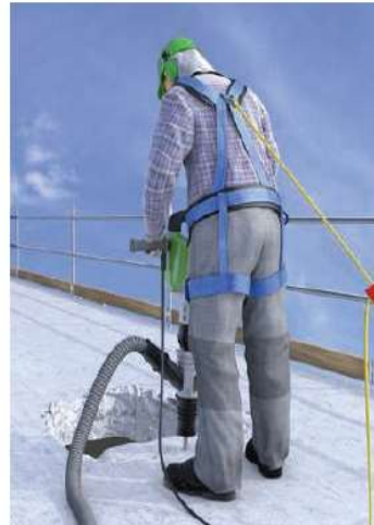
Abb. 101 Abbrucharbeiten mit PSA
