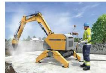
Abb. 102 ferngesteuerte Abbruchmaschine statt handgeführte Werkzeuge
