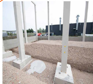
Erdbau und Tiefbau
