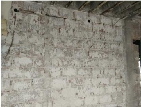
Abb. 124: Flurwand aus Mauerwerk mit R-Betonsteinen
