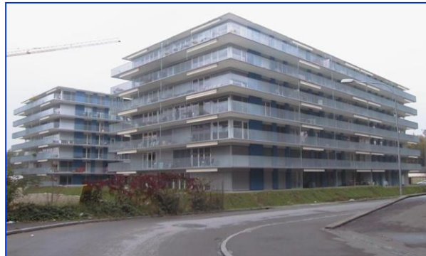
Überbauung Neubrunnstraße, Zürich-Örlikon
