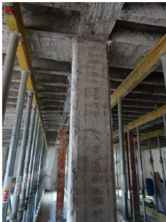
Abb. 126: Stütze aus R-Beton
