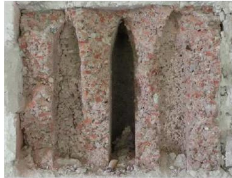
Abb. 125: R-Betonmauerstein
