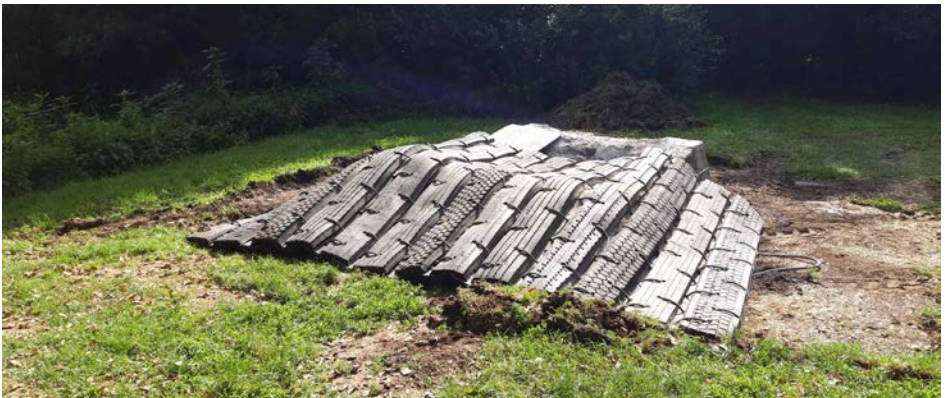
Abb. 32 Einsatz einer Sprengschuttmatte
