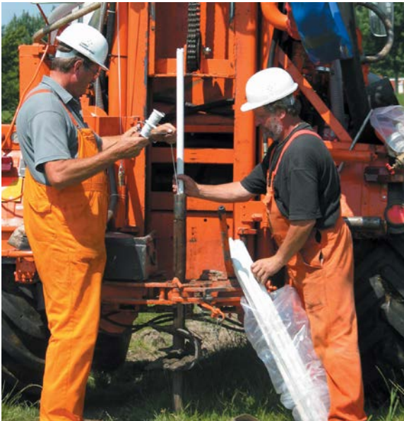
Abb. 38 Laden einer Sprengung für geophysikalische Zwecke
