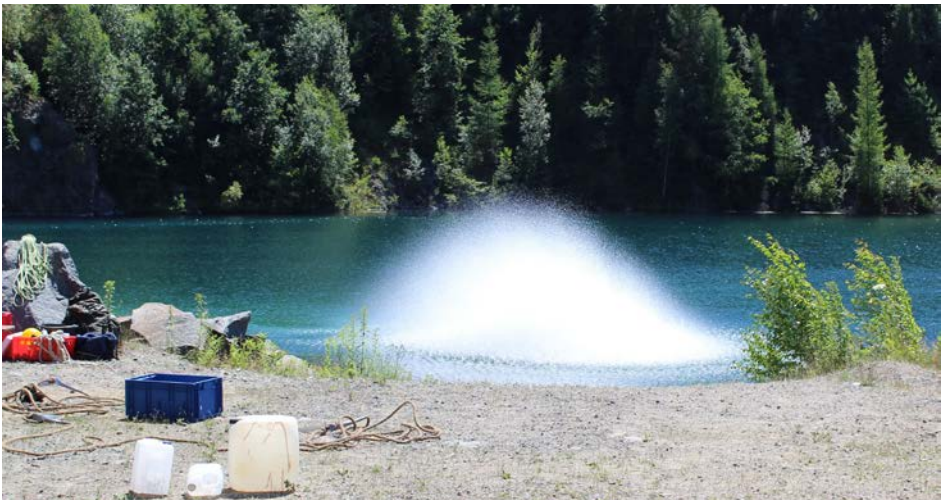
Abb. 42 Sprengung unter Wasser
