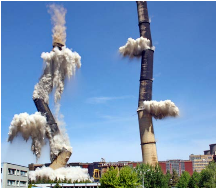
Abb. 41 Bauwerkssprengung
