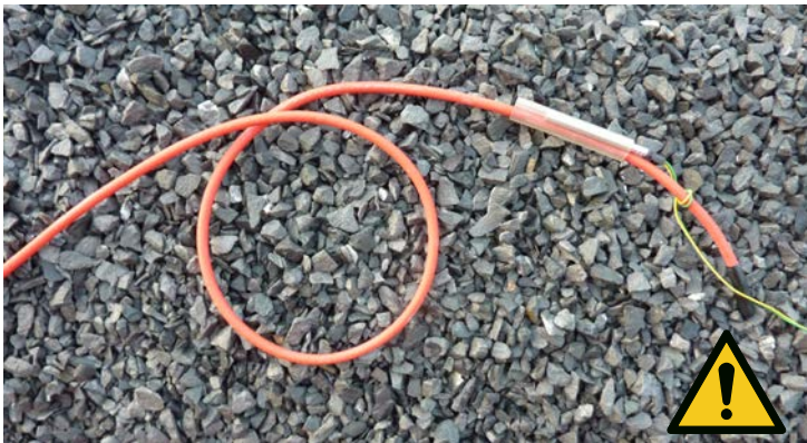
Abb. 24 Unzulässige Verlegung von Sprengschnur in einer Schlinge
