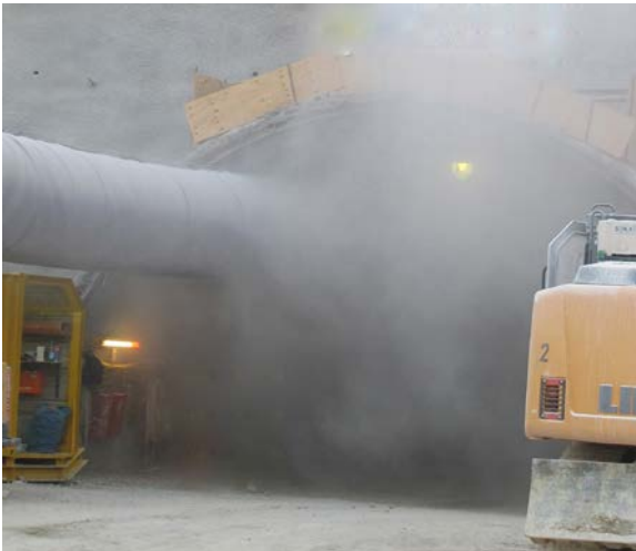
Abb. 40 Abziehende Sprengschwaden am Tunnelportal
