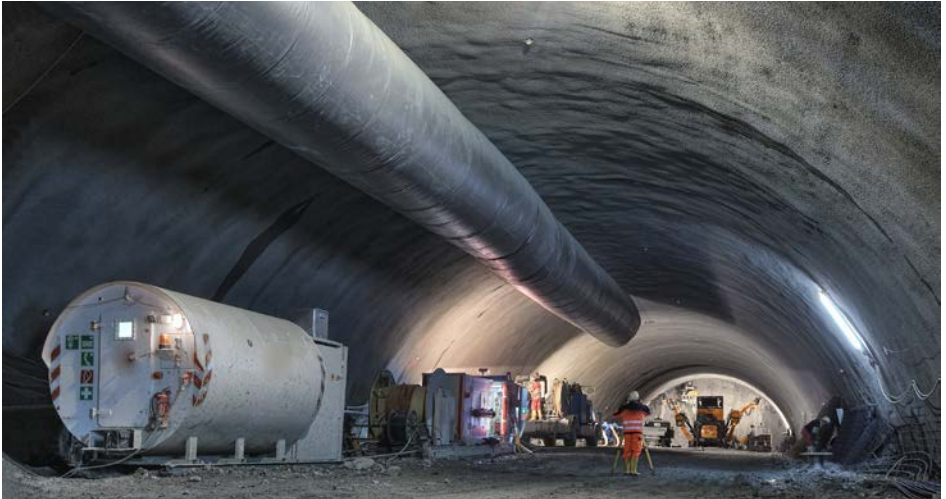
Abb. 39 Drückende Belüftung
