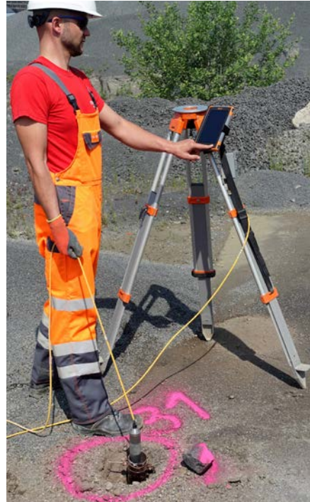
Abb. 31 Messung des Bohrlochverlaufs mit einer Bohrlochsonde
